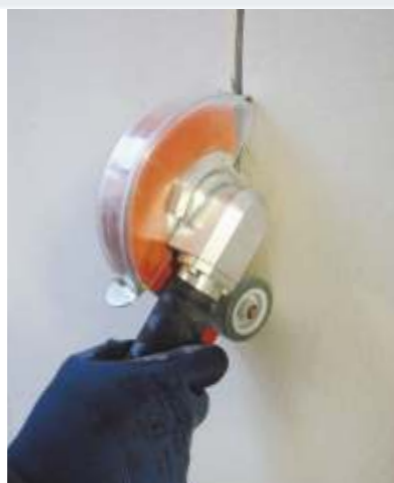
Crearea canalelor pentru cabluri electrice
